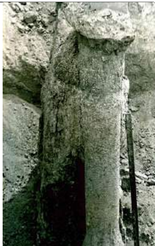
Рис. 3. Отрытая свая с уширением в торце, выполненным режущим способом
