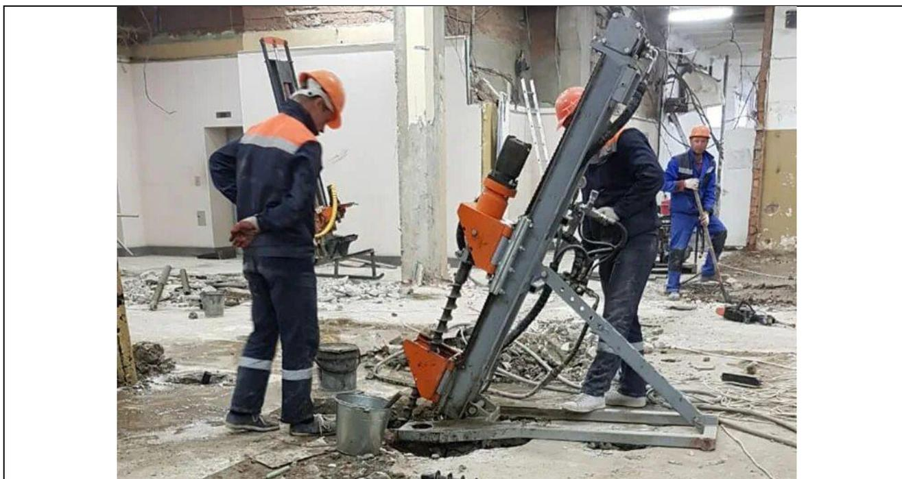
Рис. 3. Бурение наклонных скважин под иньекторы
