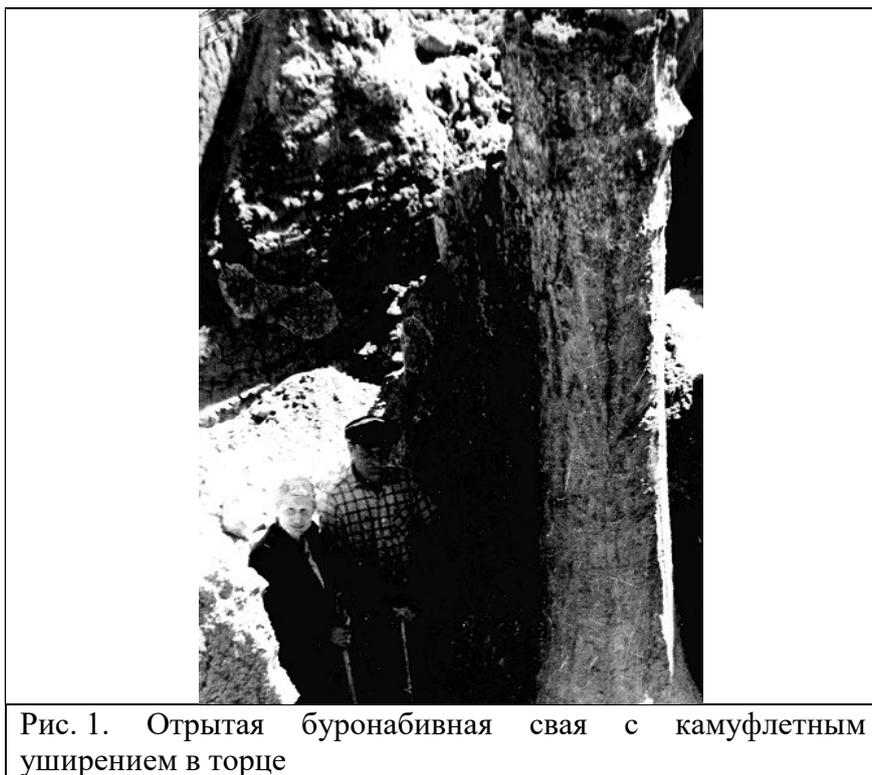
Рис. 1. Отрытая буронабивная свая с камуфлетным уширением в торце
