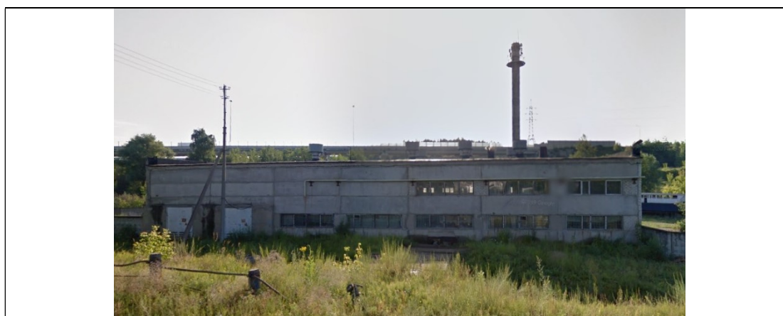
Рис. 2. Здание котельной «МО-121»
