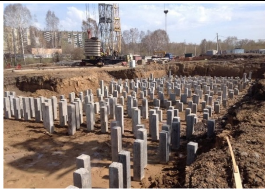
Рис. 2. Свайное поле из забивных призматических свай
