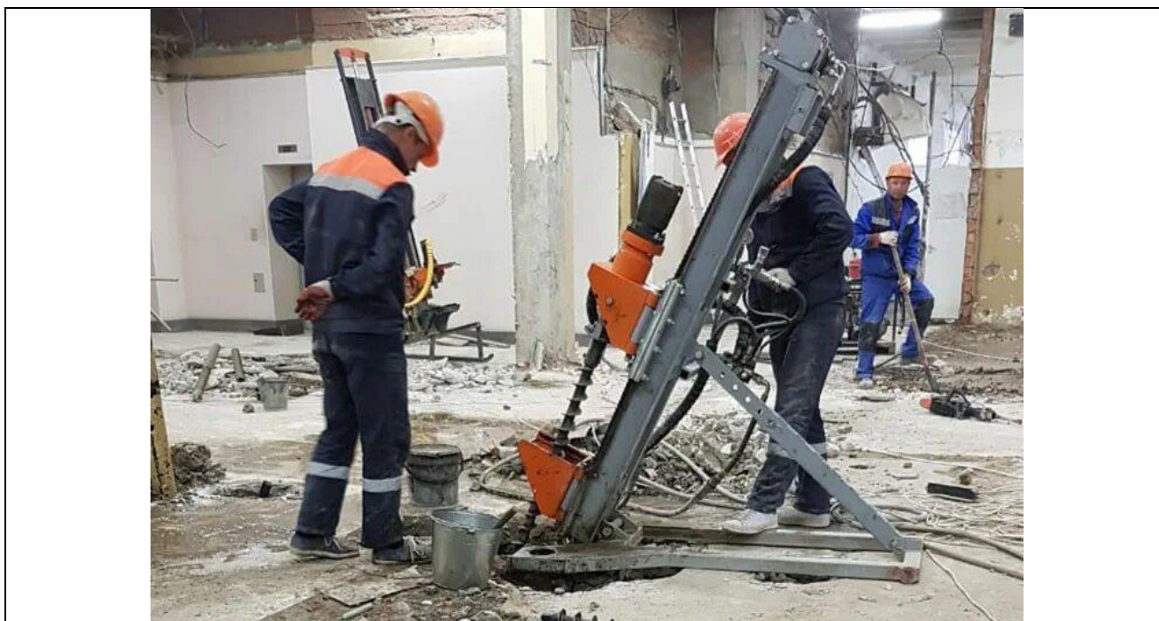
Рис. 3. Бурение наклонных скважин под иньекторы
