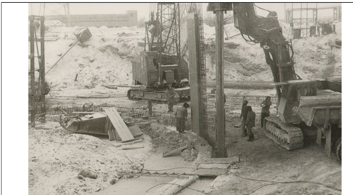
Рис. 3. Опускание сборных панелей с арматурными выпусками в траншею
