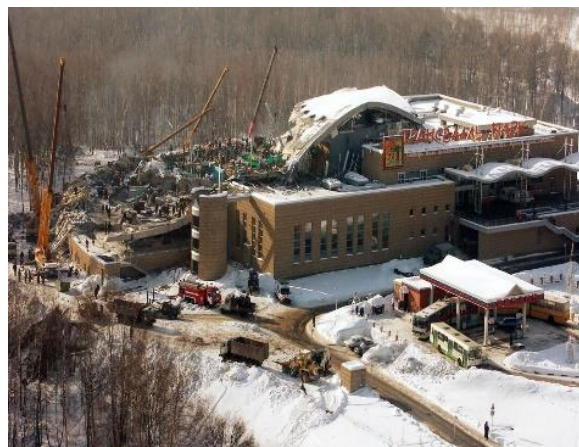
Рисунок 4 – обрушение крыши аквапарка в г. Москве
