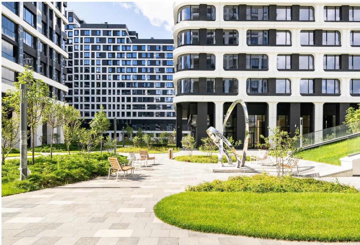
Рисунок 1 – Фасады ЖК «Остров» в г. Москва, после реконструкции навесными фасадами ЗИАС (ZIAS)
