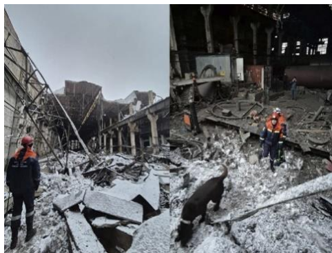
Рисунок 1 – Обрушение кровли цеха из-за наледи и снеговой нагрузки в г. Узловая
