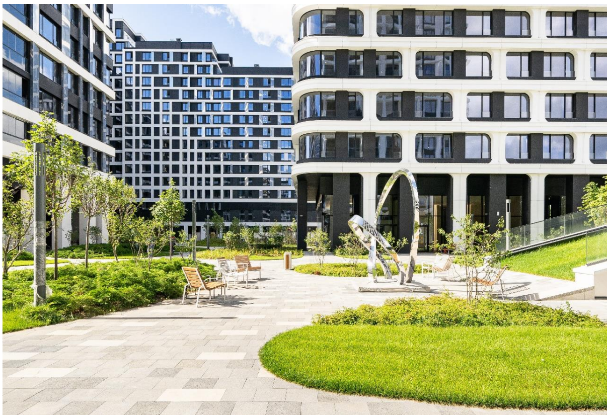
Рисунок 1 – Фасады ЖК «Остров» в г. Москва, после реконструкции навесными фасадами ЗИАС (ZIAS)
