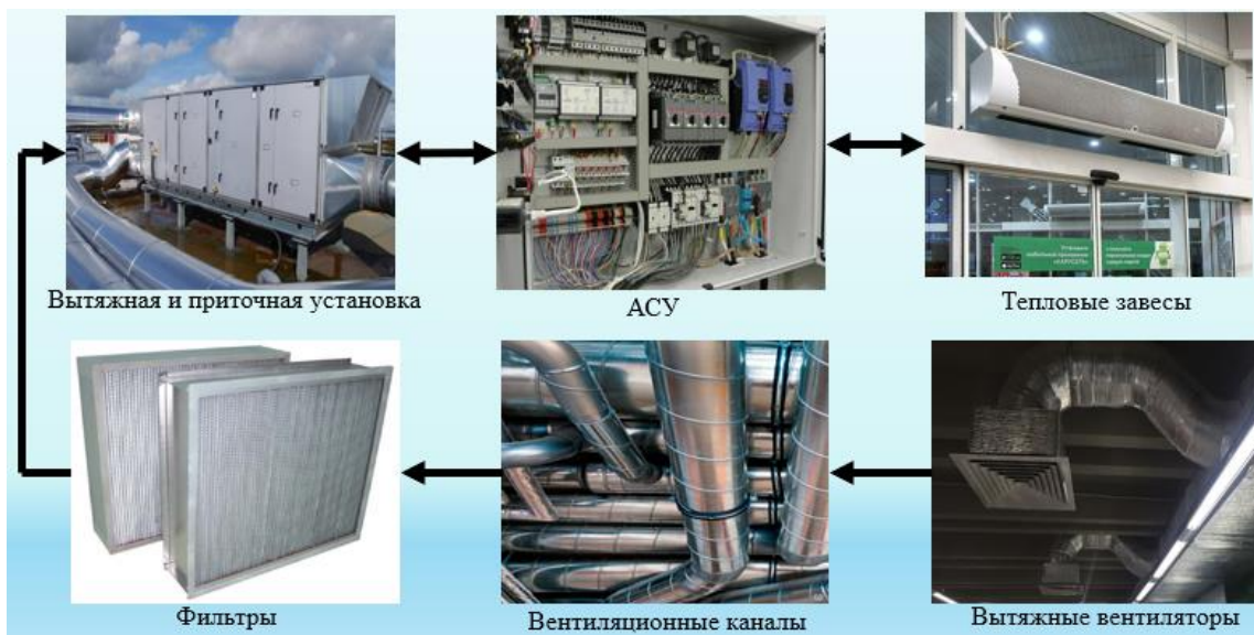
Рисунок 3 – Вентиляция и кондиционирование
